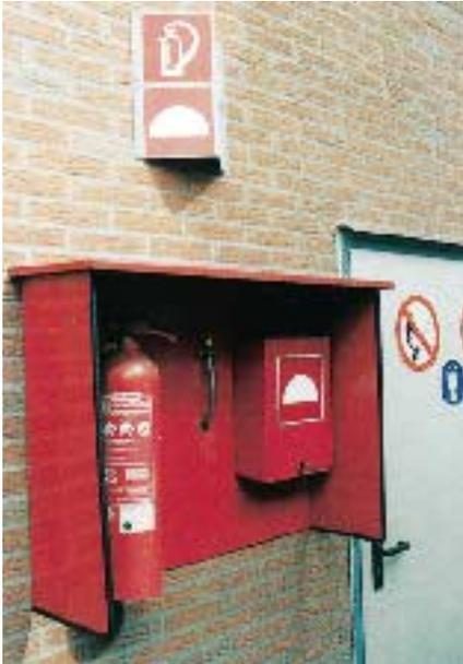
Bild 7: Feuerlöscher und Löschdecke im Betrieb
